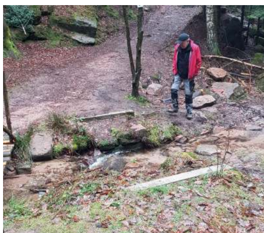
Support pour la nouvelle passerelle
